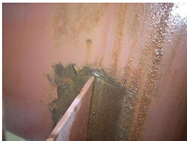
Рис. 10 Трещины в месте крепления воздухораспределителя к хребтовой балке.
